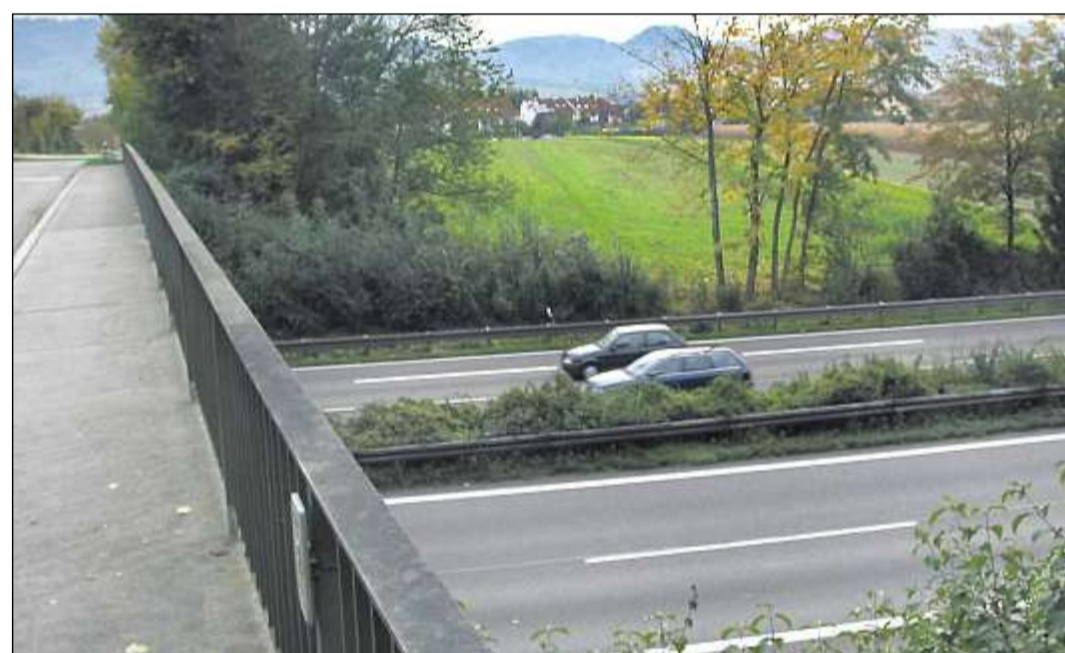
SECHSSPURIG ausgebaut wird die Autobahn auch bei Halberstung. Die bestehende Brücke wird abgebrochen und ersetzt. In Richtung des Ortes wird ein Lärmschutzwall gebaut. Foto: Roland Huck
