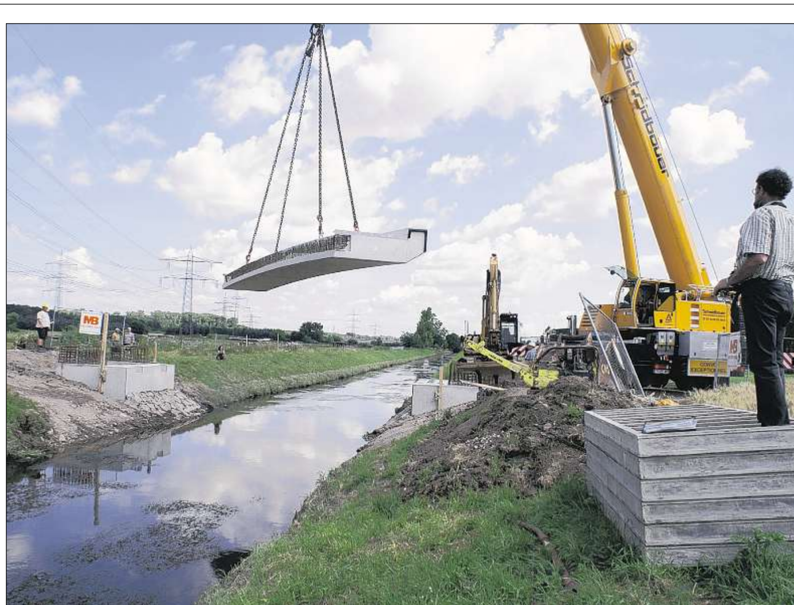
MILLIMETERARBEIT erfordert der Bau einer neuen Brücke über den Sandbach bei Halberstung. Tonnenschwere Fertigteile wurden per Kran an ihre künftige Position gehievt. Insgesamt sind für den Neubau 130 000 Euro im Haushalt veranschlagt. Foto: Roland Huck
