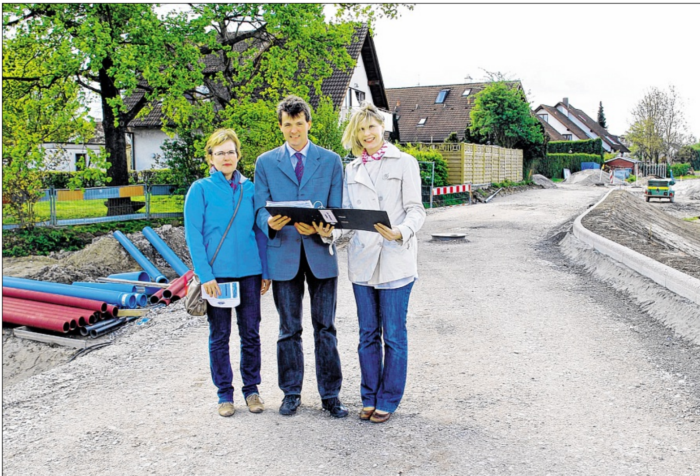
DAS NEUBAUGEBIET HALBERSTUNGER FELD wird erschlossen: (von links) Gerda Lemay, Bürgermeister Erik Ernst und Hauptamtsleiterin Christina Braun planen familienfreundliche Baugrundstücke. Foto: Alois Huck
