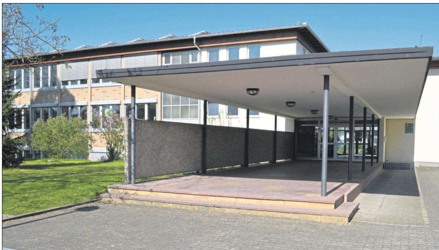
IM SÖLLINGER SCHULGEBÄUDE sollen künftig die Grundschüler aus Schwarzach, Söllingen, Stollhofen und Hildmannsfeld unterrichtet werden. Der Gemeinderat stellte mit der Vergabe von Sanierungsarbeiten die Weichen. Foto: Gangl
