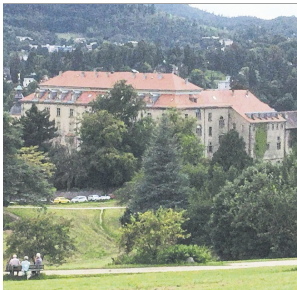
WAS WIRD AUS DEM NEUEN SCHLOSS? Die Investorin hält weiter an einer Hotelnutzung fest, jedoch nur im historischen Gebäude und nicht im Anbau. Foto: Kappler
