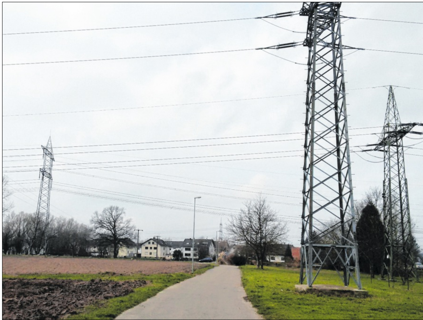
GLEICH MEHRE FREILEITUNGEN führen an Halberstung vorbei. Im Zuge anstehender Umbaumaßnahmen wird nun ein größerer Abstand der bisherigen 220-kV-Leitung (im Hintergrund/hohe Masten) von der Bebauung geprüft. Foto: Roland Huck
