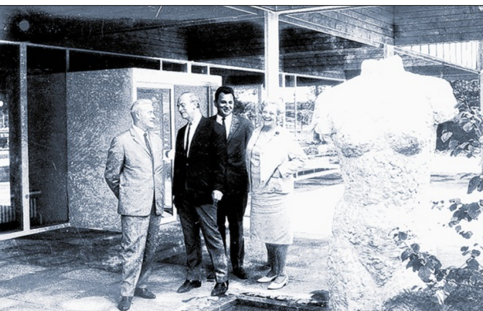
DIE RASTSTÄTTE BÜHL wurde vor einem halben Jahrhundert eröffnet: (von links) Wilhelm Wolter, Chef des Landesautobahnamtes, Architekt Paul Stohrer, dessen Bauleiter Rolf Dieter und die Bildhauerin Olga Waldschmidt in zentralen Atrium. Foto: ABB-Archiv
