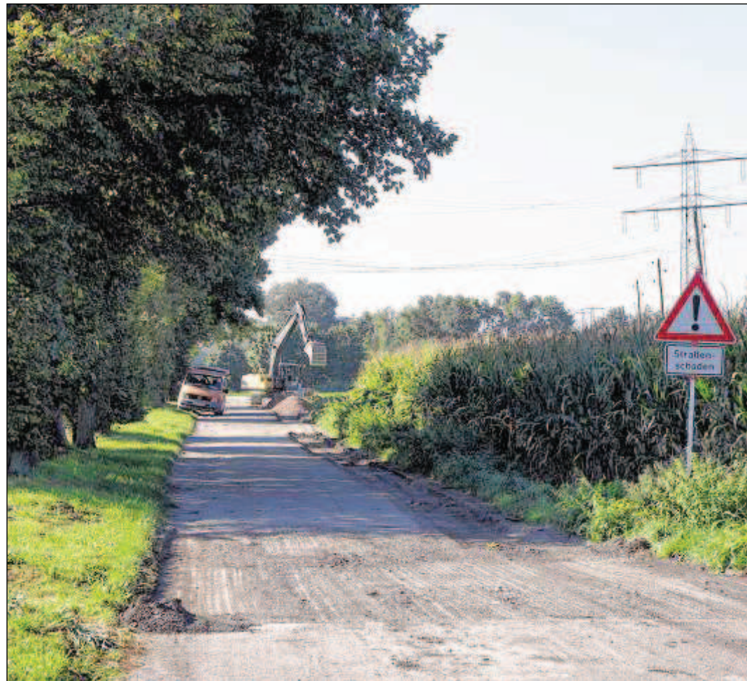
DER GEMEINDEVERBINDUNGSWEG zwischen Weitenung und Halberstung wird saniert. 15 Jahre lang wurde über den Zustand der Straße diskutiert.
