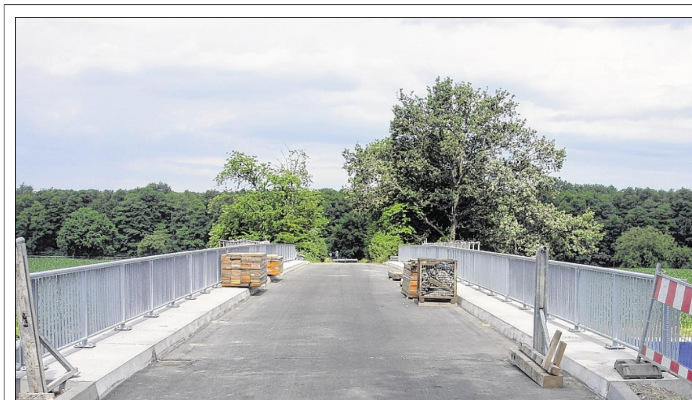
NUR NOCH ETWAS BAUMATERIAL stand laut Karl Leo Knopf zum Schluss auf der Brücke zum Langenunger Hof. Laut Schriftführer der Bürgervereinigung Halberstung hätte das Bauwerk deshalb früher frei gegeben werden können. Foto: pr
