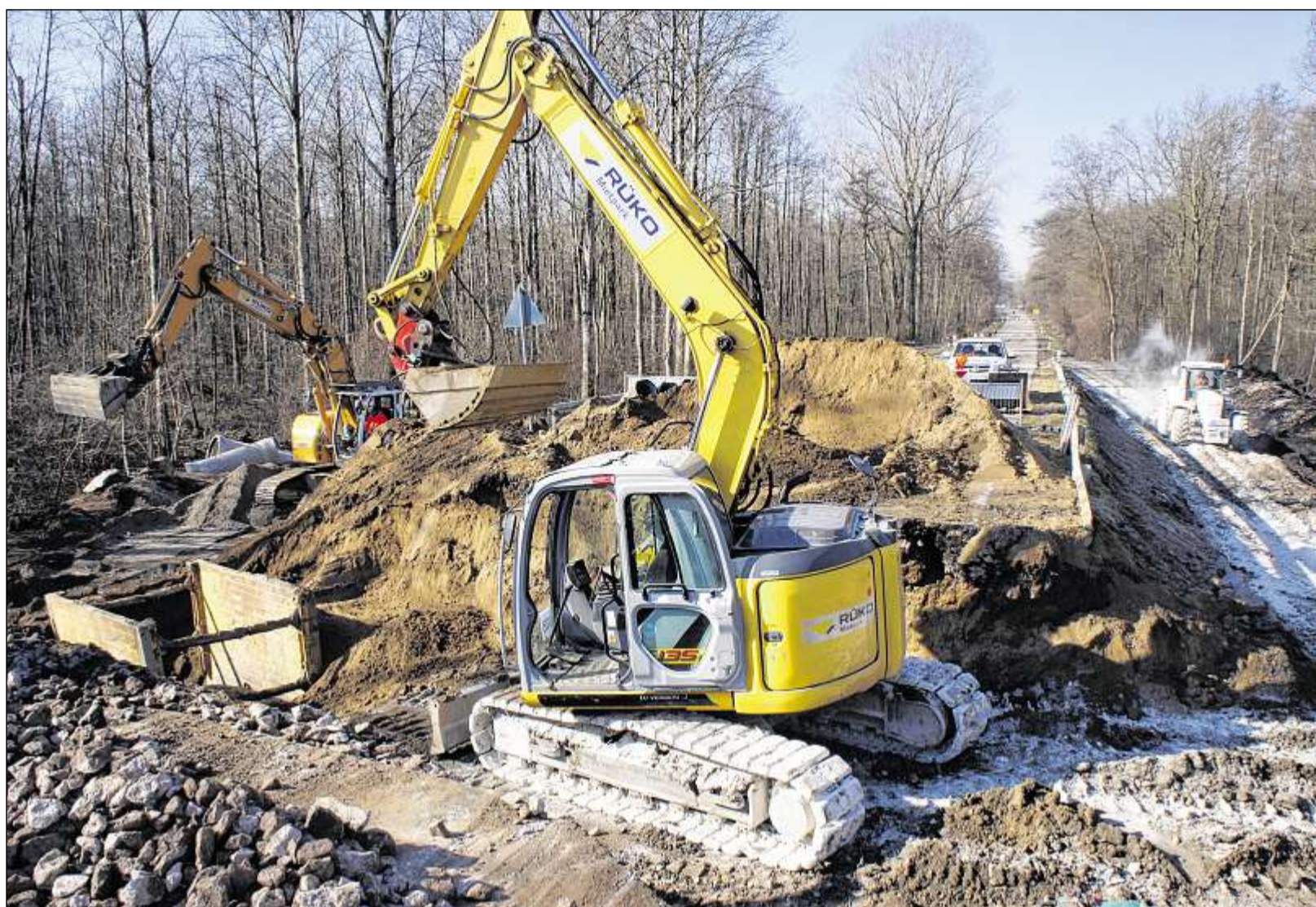
BAGGER IM EINSATZ: Unser Foto zeigt die Baustelle in Richtung Leiberstung. Die Straßenrampe der Landesstraße 80 ist komplett durchschnitten. Heute rollt der Verkehr wieder. Foto: Knopf
