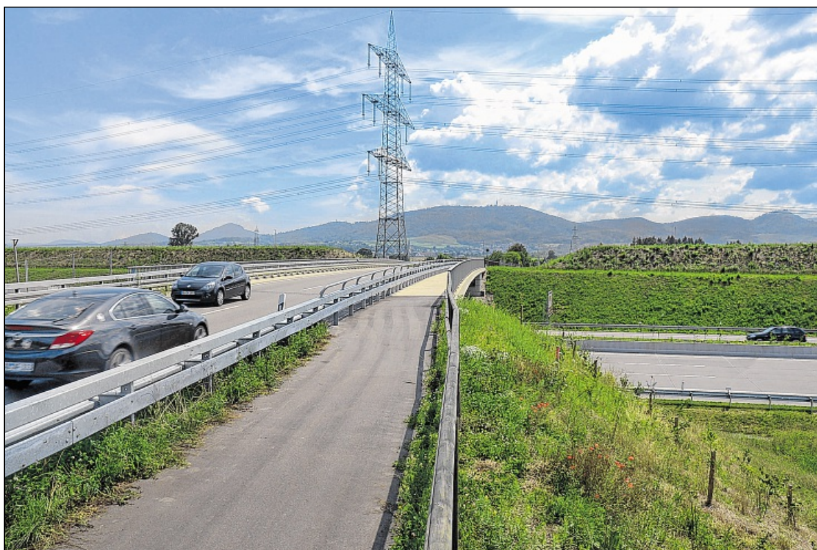
AUTOBAHNANSCHLUSS AIRPARK: An dieser Stelle, an der die L 80 über die Autobahn geführt wird, soll der Airpark an die Verkehrsachse angebunden werden. Foto: Collet
