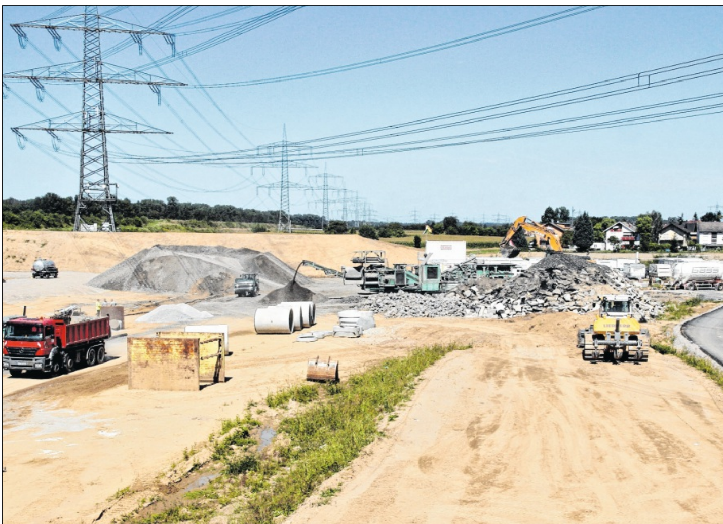
GROSSBAUSTELLE: An der Tank- und Rastanlage Bühl entsteht aktuell ein neuer Parkplatz. Die Bauarbeiten haben im November begonnen und dauern voraussichtlich bis Mitte des nächsten Jahres. Foto: Margull
