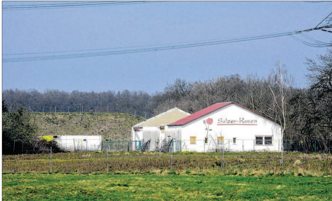
OHNE DACH: Die Halle der Rosengärtnerei ist inzwischen abgedeckt. Sie soll der Erweiterung der Autobahnraststätte Bühl weichen, die Ende des Jahres beginnen soll.
