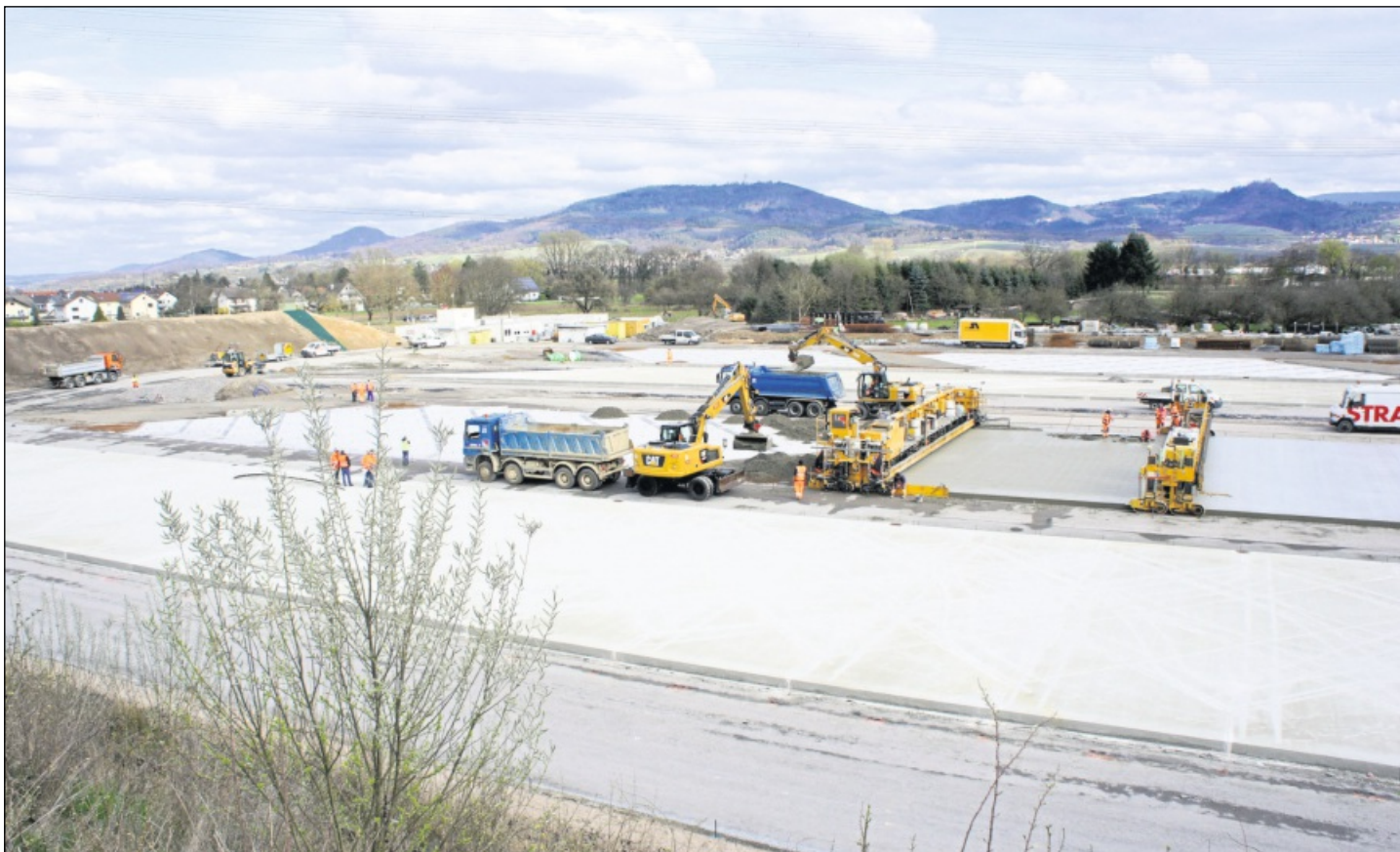
DIE TANK- UND RASTANLAGE BÜHL soll noch in diesem Jahr vollendet werden. Die Bauarbeiten für die Erweiterung haben im benachbarten Halberstung immer wieder für Kritik gesorgt. Foto: Knopf
