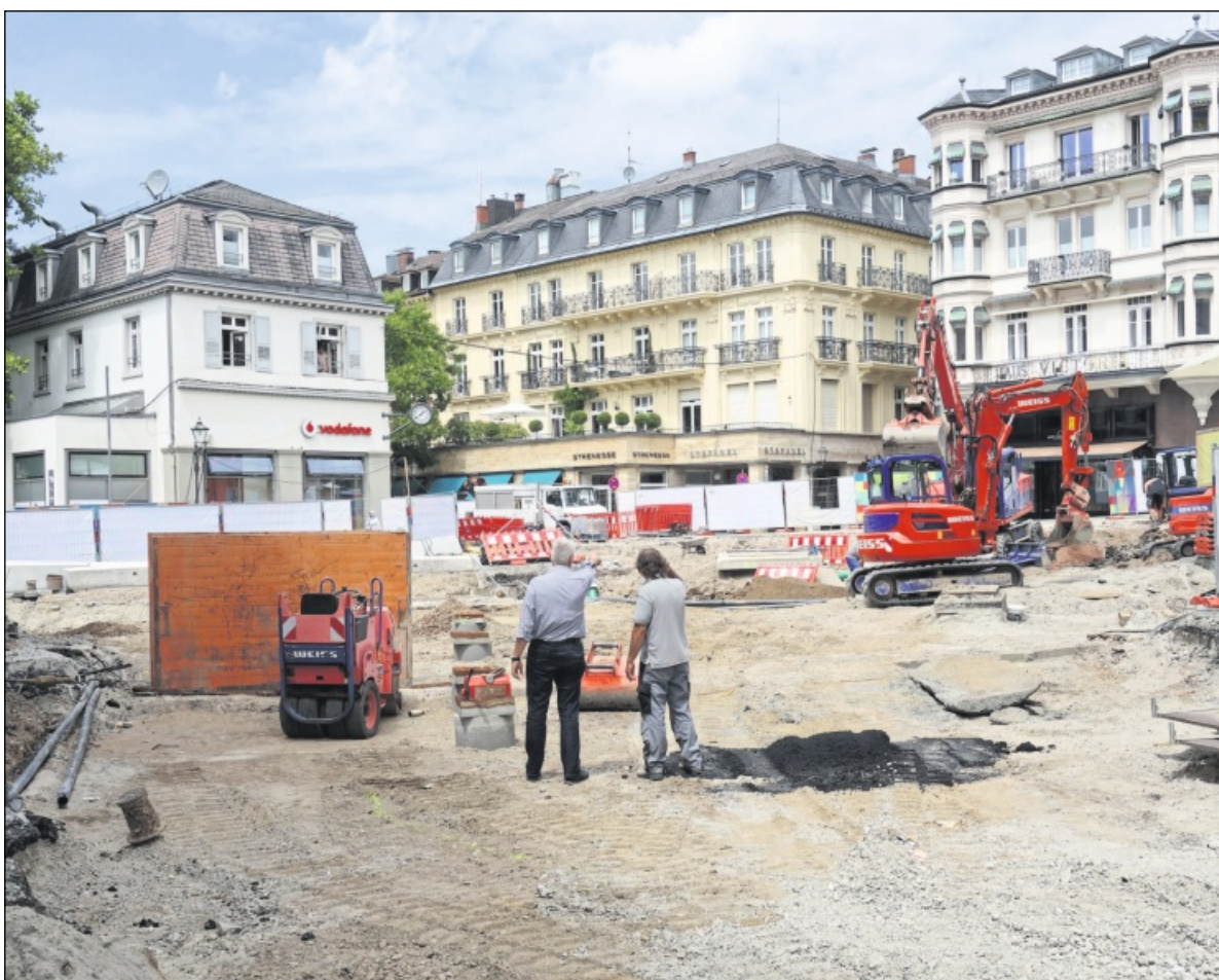
KÜNFTIG MEHR KOSTENSICHERHEIT? Die Stadt möchte bei großen Bauvorhaben wie dem Leopoldsplatz nach einem mehrstufigen Verfahren vorgehen, das den Gemeinderat stärker einbindet als bisher. Foto: Rudolphi
