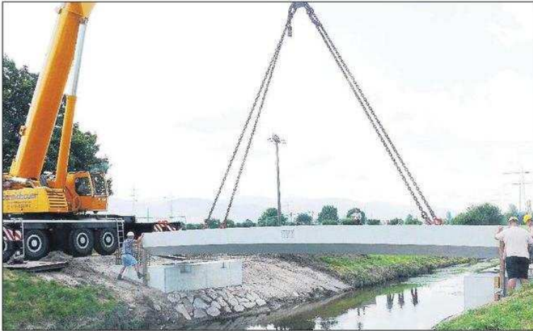
Zwei große Fertigbauteile bilden in Zukunft die neue Rosenhofbrücke über den Sandbach. Der alte Überweg war seit 2007 wegen Baufälligkeit für den Verkehr gesperrt. Foto: Vögele
