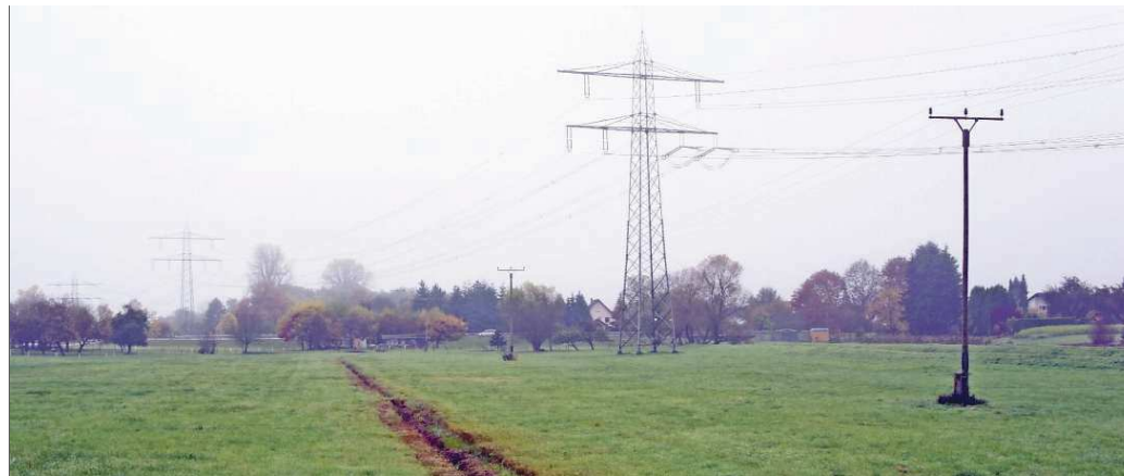
Die großen Masten hier bei Halberstung gehören zur 220-kV-Hochspannungstrasse, die aufgerüstet werden soll. Der kleine Holzmast trägt die 20-kV-Leitung des untergeordneten Stromnetzes.
