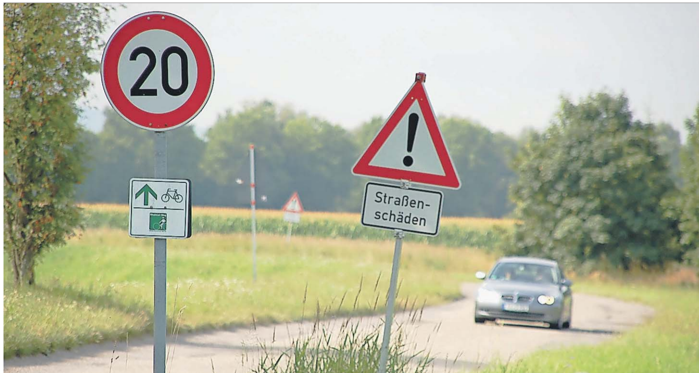
Etwa alle 100 Meter warnen Hinweisschilder vor Straßenschäden auf dem Rasthofweg.
