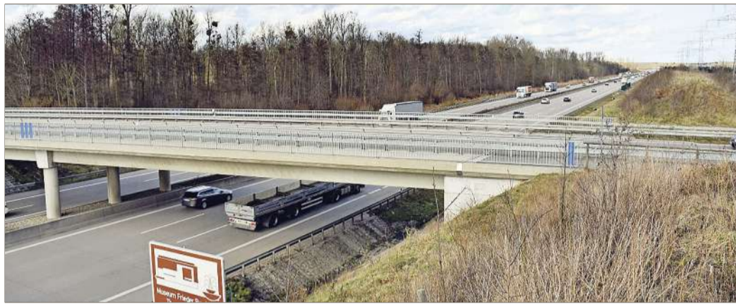
Ein Stück des Lärmschutzwalls an der A5 bei Halberstung (rechts hinten) soll bei einer Realisierung des Autobahnanschlusses zurückgebaut werden.
