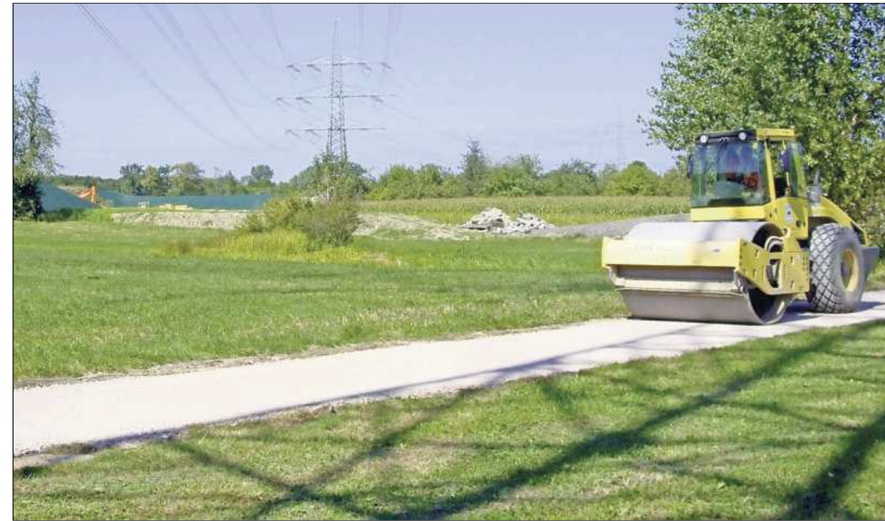
Ein bisher unbefestigter Feldweg bei Halberstung wird von einer Walze mit Mineralbeton befestigt.
