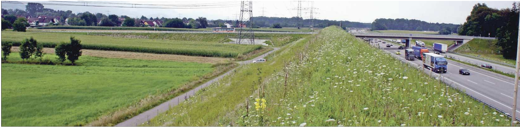
Links vom Wall, der zurückgebaut werden soll, ist der neue A5-Anschluss vorgesehen – nur wenige Meter von Halberstung entfernt. Weiter geht es dann über die A5-Brücke.
