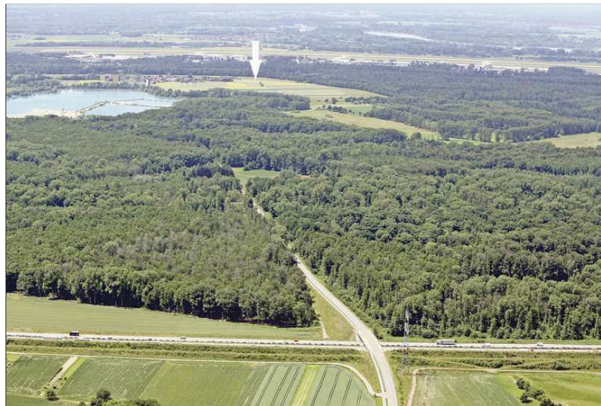
Nach dem Bau eines neuen A5-Anschlusses bei Halberstung soll der Verkehr über die vorhandene Brücke und weiter über Schiftung (Pfeil) zum Baden-Airpark rollen. Foto: Willi Walter
