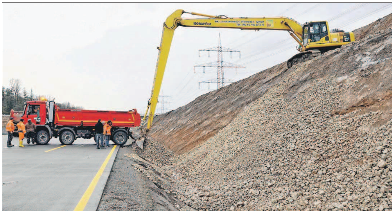
Langarmbagger schütten in zeitintensiver Arbeit den Lärmschutzwall mit Schotter an.
