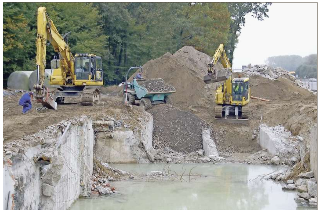
Nur noch ein großes Loch ist von der Tankstelle beim Rasthof Bühl geblieben. Die neue Anlage geht im April 2016 in Betrieb.
