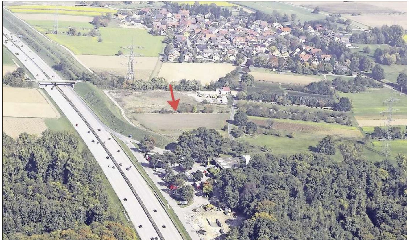
Die Tankstelle ist bereits verschwunden (Bild unten), neue Parkplätze entstehen Richtung Norden (Pfeil).
