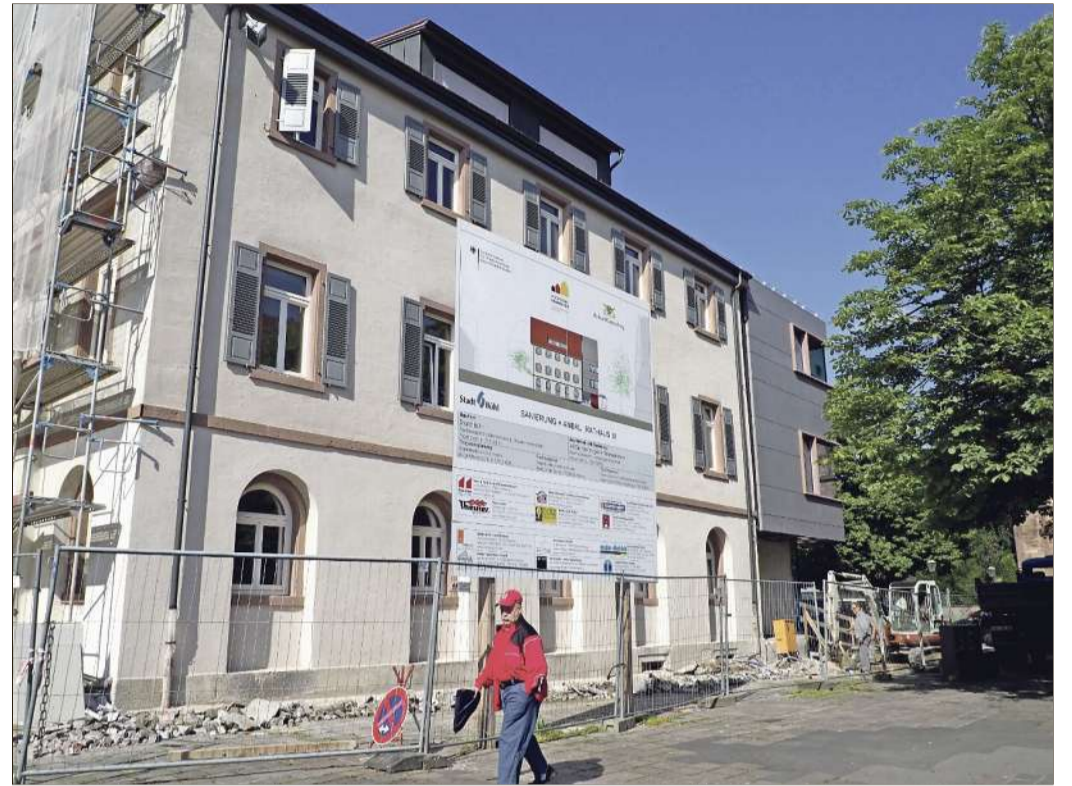
Blick auf die Nordfassade des Gebäudes aus Richtung Hauptstraße: Der Anbau hebt sich deutlich vom historischen Bestand ab. Fotos: Siebnich
