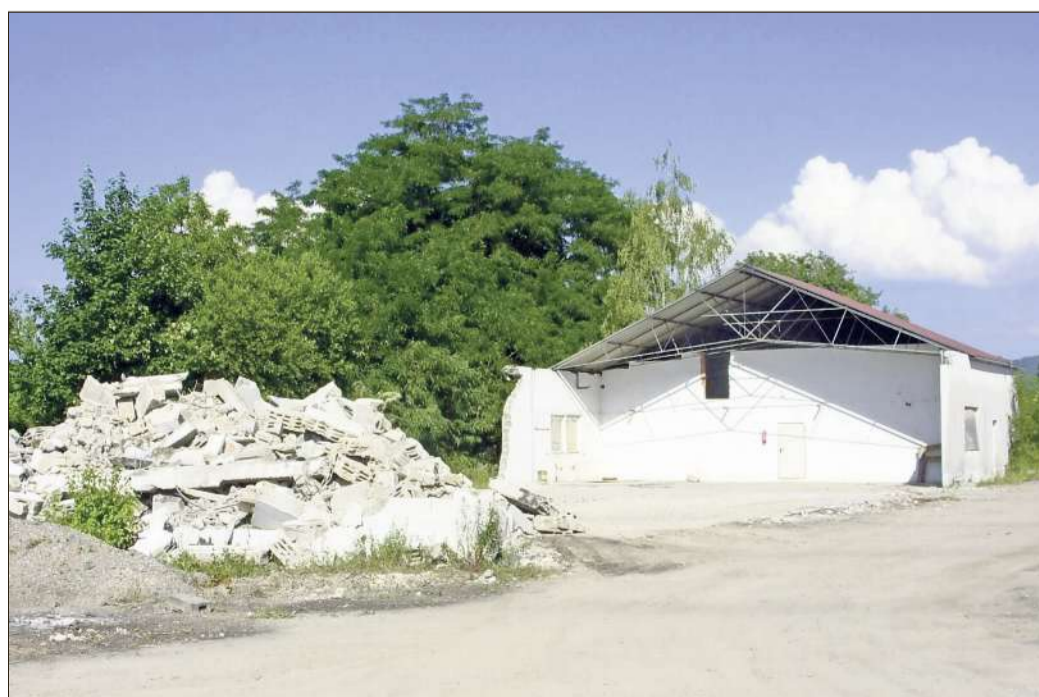
Die ehemalige Rosengärtnerei bei Halberstung weicht dem Ausbau der Tank- und Rastanlage Bühl. Foto: Knopf
