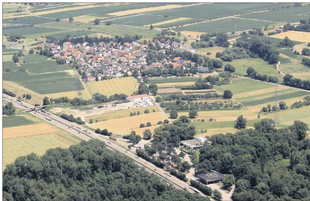
Bis an die nördlich der Tank- und Rastanlage Bühl (rechts vorne) gelegene Wirtschaftswegbrücke über die A5 (links) soll der neue Großparkplatz reichen. Im Hintergrund liegt Halberstung. Foto: Walter/av
