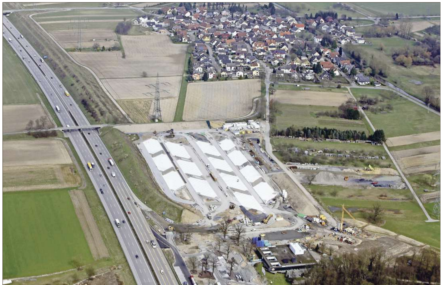
Blick auf die Parkplatz-Großbaustelle an der Tank- und Rastanlage Bühl. Im Hintergrund Halberstung.
